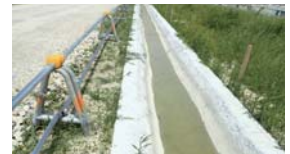
施工エリア外周部雨水側溝
