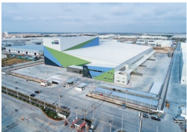
UNICORN 1 新工場建設工事
