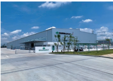
HANWA METAL (THAILAND) 新工場建設工事
