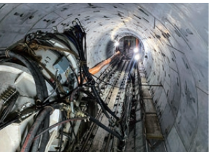
トンネル初期掘進
