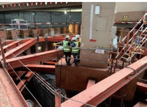
アンダーピニング施工状況
