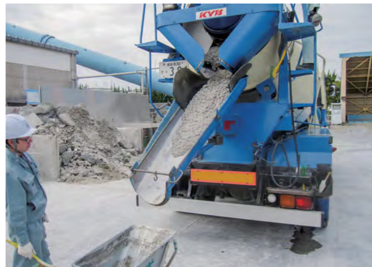
鉄の製造過程で出る副産物を利用し製造した低炭素型コンクリート
