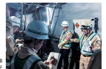
立野ダム建設工事現場見学会の様子
