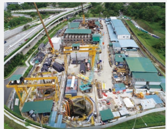
トンネル発進基地全景
