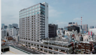
環状第二号線新橋・虎ノ門地区 再開発事業Ⅰ街区
