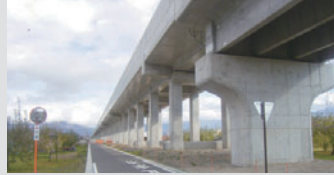
北陸新幹線小布施高架橋
