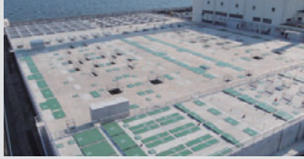
南部水再生センター水処理施設
