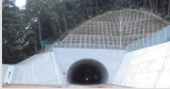
大田防災大田トンネル
