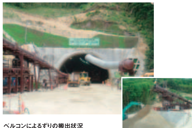
ベルコンによるずりの搬出状況
