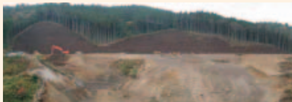
吹付け完了直後（平成19年11月）
