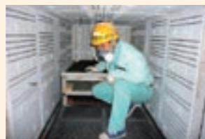
炉内へのアスベスト含有建材セット状況
