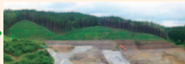
吹付け後8ヶ月（平成20年6月）
