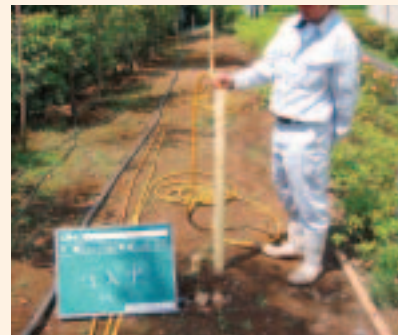
微生物の栄養源を地盤に注入している状況
