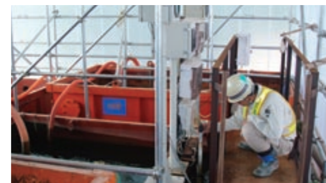
濁水処理施設点検
