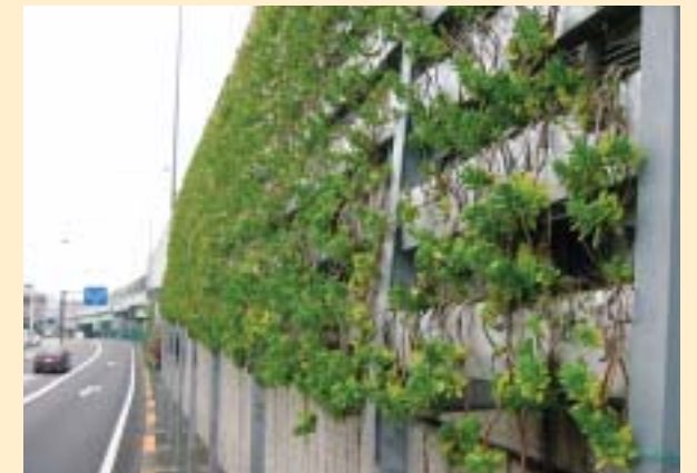
東六郷橋壁面緑化状況
