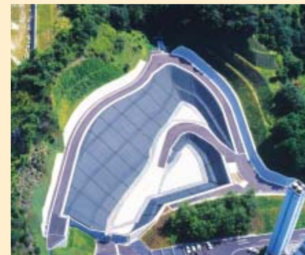
大野城最終処分場(「しゃ水シート+土質しゃ水」のタイプ)
