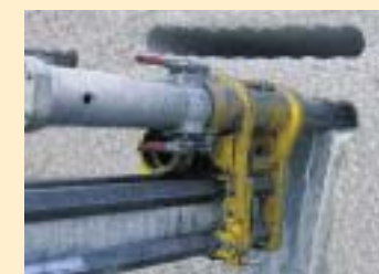
自由面の施工状況 注:「EG-Slitter」は戸田建設(株)との共同開発です。
