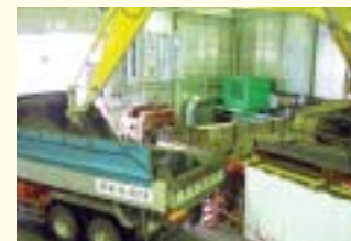
トンネル掘削土砂の再利用
