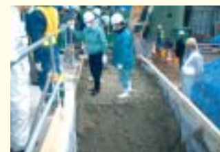
建設汚泥リサイクルシステムの一般公開状況
