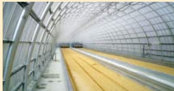
発酵堆肥化システム
