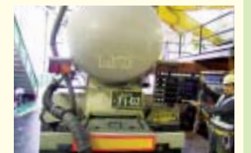
裏込め材はタンクローリーで搬入
