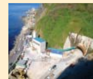
トンネル坑口
