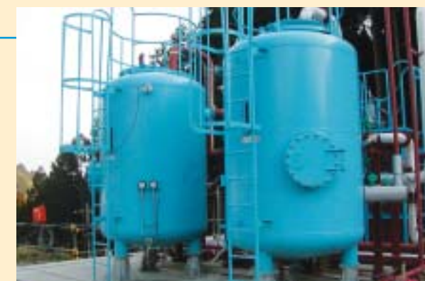
高度処理に用いた砂ろ過装置
