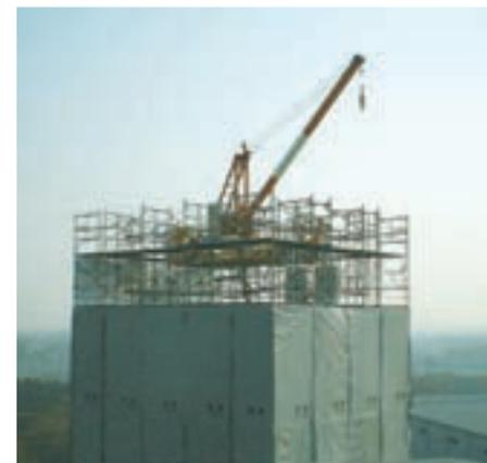
煙突解体用小型クレーンの設置
