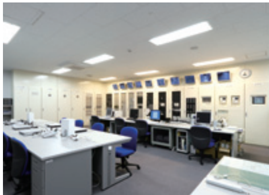
中央監視室(建物のエネルギー管理を行っている)
