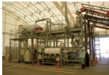
スーパースチーム工法 過熱蒸気処理プラント外観
