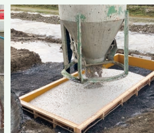
Placing (bucket)
