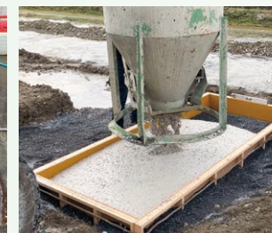
Placing (bucket)
