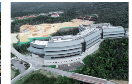
沖縄科学技術大学院大学第4研究棟新営その他工事
