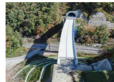
国道45号 萩牛北地区道路工事
