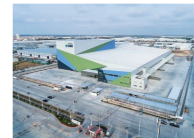
UNICORN 1 新工場建設工事
