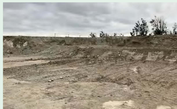
場内「自ら利用」土砂
