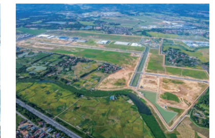
第3タンロン工業団地 第2、3期造成・インフラ工事
