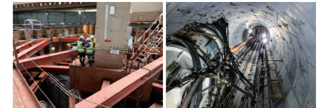
アンダーピニング施工状況
