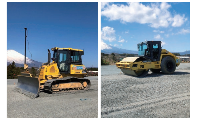
マシンコントロールブルドーザーと3D盛土情報管理システム搭載ローラーの活用
