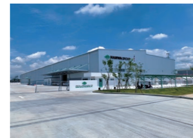
HANWA METAL (THAILAND) 新工場建設工事
