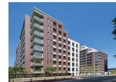
藤崎公園住宅マンション建替え計画新築工事
