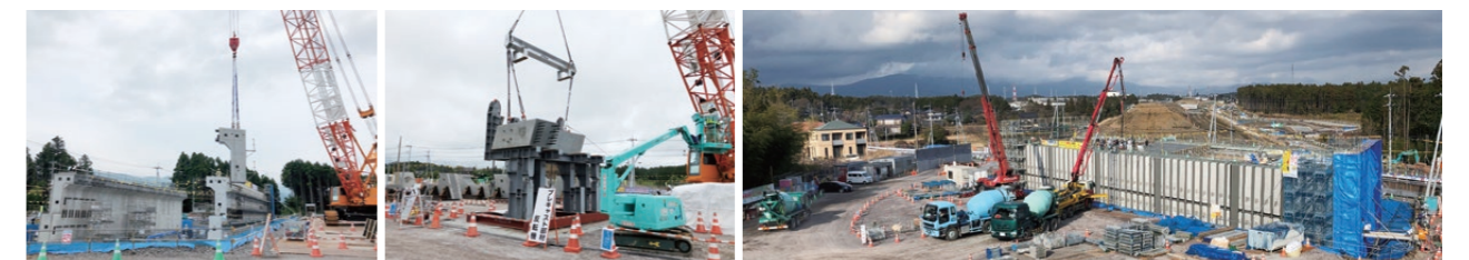
ハーフプレキャストBOX部材 据付け施工状況
