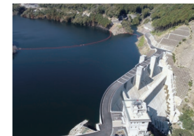
平成28-31年度横瀬川ダム本体建設工事
