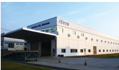
FSTH Project, Thailand
