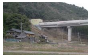
防音シェルター
