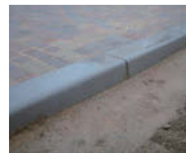
校舎外構に使用したジオポリマー外構ブロック
