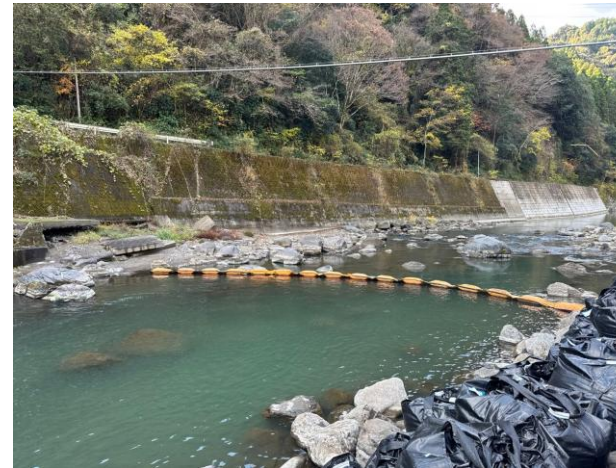
<シルトフェンスの設置>
