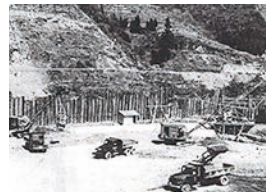
荒瀬ダム機械化施工のモデル現場
