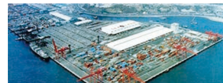
香港クワイチンコンテナヤード
