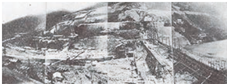
朝鮮赴戦江漢堡里堰堤コンクリート工事全景
