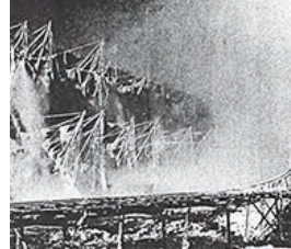
氷結時の工事中的葛田里堰堤（昭和10年11月）
