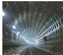
京葉線羽田沖トンネル
