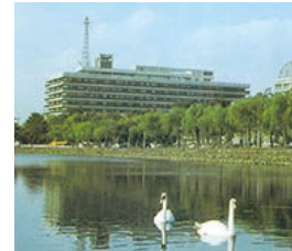
大手町第一合同庁舎
