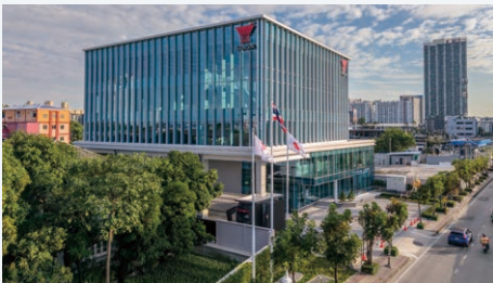
ユアサ商事 バンコク事務所新築工事
