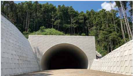
長崎497号松浦1号トンネル新設工事
