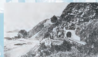
肥薩線第2工区
