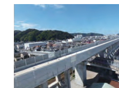
第3南福井高架橋
