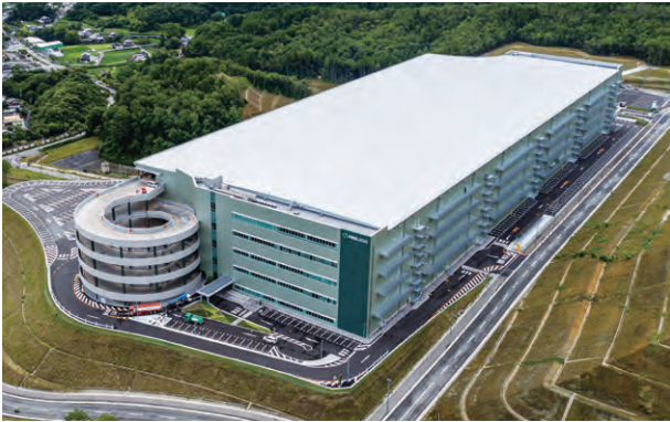
西日本支社 猪名川建築工事 全景
