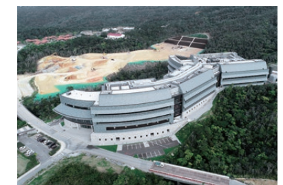
沖縄科学技術大学院大学第4研究棟新営 その他工事
