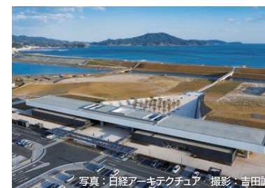
高田松原国営追悼・祈念施設（仮称） 管理棟建築工事
