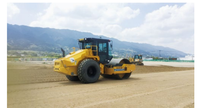
ICT施工 (GNS5 ® ローラー締固め管理) による施工状況
