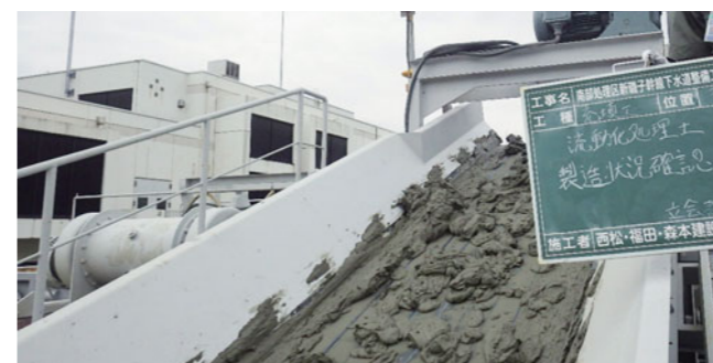
シールド掘進時に発生する建設汚泥を用いて流動化処理土を製造
