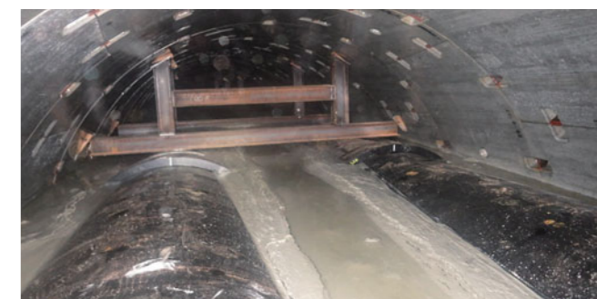
製造した流動化処理土をシールド坑内に充填
