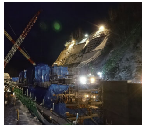
省エネのため、全現場で工事用仮設照明をLED化
