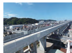
第3南福井高架橋
