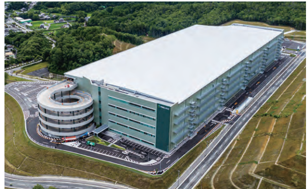
西日本支社 猪名川建築工事 全景
