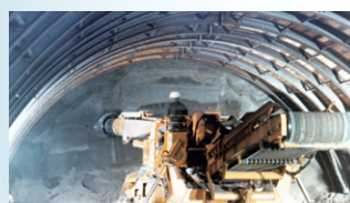
青函トンネル(千軒工区)
