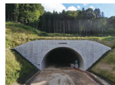
南湖トンネル
