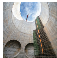
リニア中央新幹線梶ヶ谷非常口・資材搬入口
