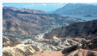
香港 ロア・シンマン・ダム
