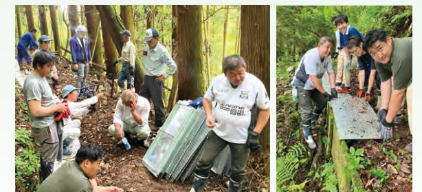
地元水路への鉄板敷設作業を地元自治会と共同で実施
