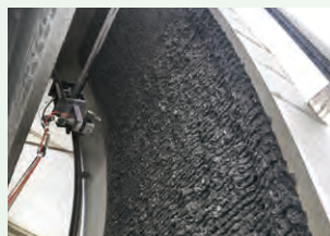
既設覆工切削技術開発 WJ 切削
