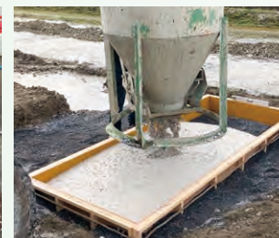
打込み状況（バケツ）
