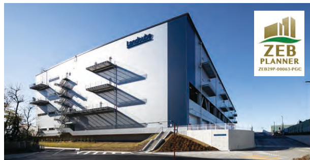
Landcube上尾(物流倉庫 S造、地上4階 延床面積:39,859㎡) ※設計・施工受注案件として初めて「ZEB認定」を取得。このほか、ZEB Readyの実績10件、ZEHの実績5件(認証取得予定を含む)
