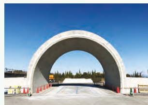
再生覆工技術開発打設完了
