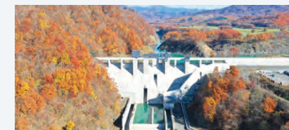
北海道の平取ダム堤体建設工事
