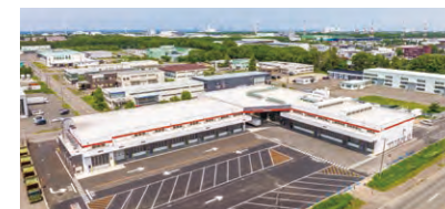
石狩新港西工事 全景 受賞テーマ「様々な制約を受ける大規模工業団地内の建設工事における積極的3R活動」
