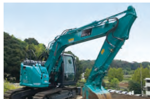
バックホウにおけるRDの使用感および燃費性能の検証 (関東建築支社 慶應藤沢出張所)
