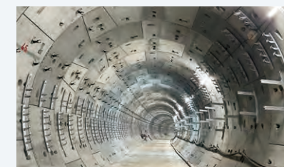
地下鉄サークルライン・ケッペル駅のトンネル
