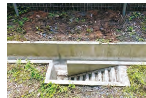
側溝の小動物用階段 (関東土木支社 南巨摩工事事務所)
