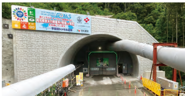
工事電力の100%を再エネ電力としているトンネル現場 (四国支店 不破原トンネル出張所)
