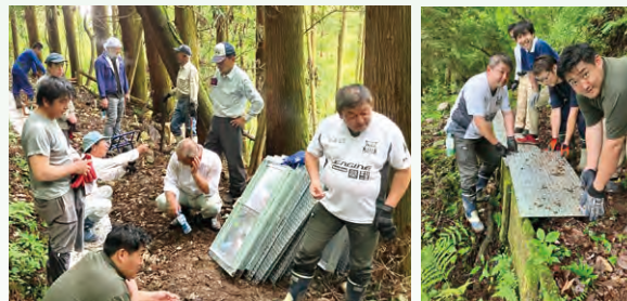
地元水路への鉄板敷設作業を地元自治会と共同で実施
