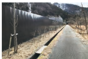
アースカラーの仮囲い (関東土木支社 南巨摩工事事務所)
