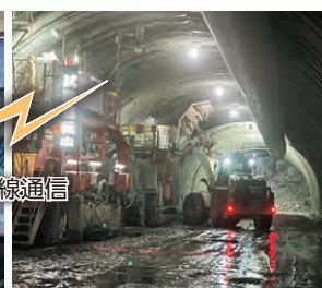
ホイールローダ遠隔操作システム（Tunnel RemOS-WL）の現場適用試験状況
