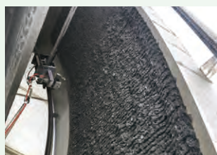
既設覆工切削技術開発 WJ 切削
