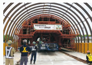
多軸台車を用いたセントル移動試験
