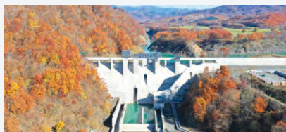
北海道の平取ダム堤体建設工事
