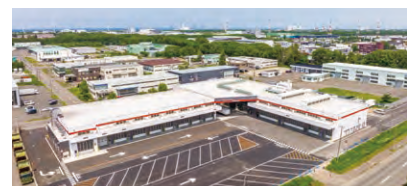
石狩新港西工事 全景
