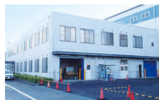
愛川技術研究所 外観
