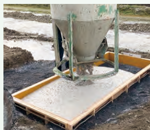
打込み状況 (バケツ)
