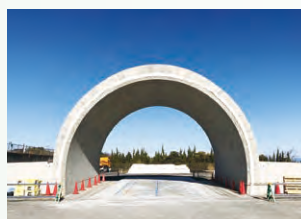
再生覆工技術開発打設完了
