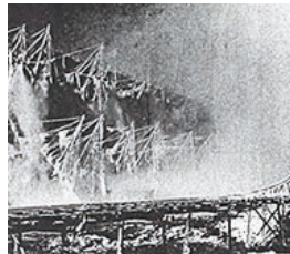
氷結時の工事中の葛田里堰堤 (昭和10年11月)
