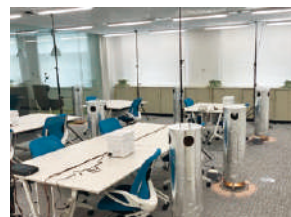
模擬負荷による空調性能試験
