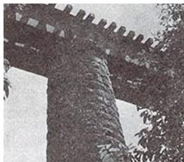
宮崎線唐仁田鉄橋
