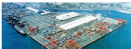
香港クワイチンコンテナヤード
