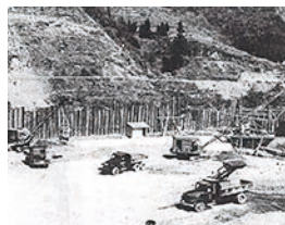
荒瀬ダム機械化施工のモデル現場
