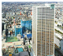
武蔵小杉駅南口地区再開発
