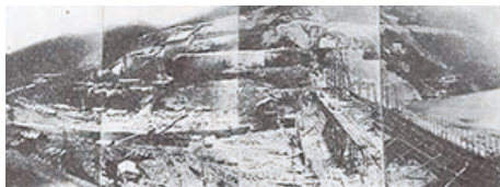
朝鮮赴戦江漢垓里堰堤コンクリート工事全景
