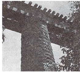
宮崎線唐仁田鉄橋
