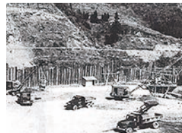
荒瀬ダム機械化施工のモデル現場
