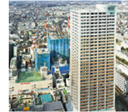
武蔵小杉駅南口地区再開発
