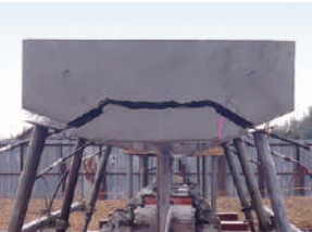
板ジャッキによる割裂実験
