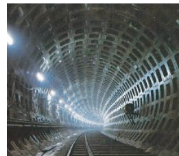
京葉線羽田沖トンネル
