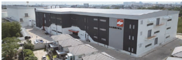
米国 SANMINA 社の電子通信機器製造工場 (タイ)
