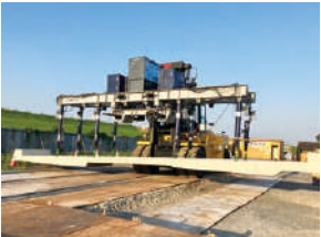
大型フォークリフトと専用架設装置を用いた実大運搬設置実験
