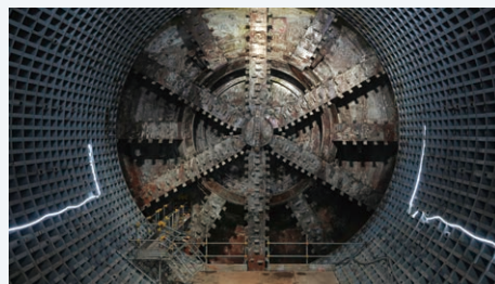
横浜湘南道路トンネルその3工事
