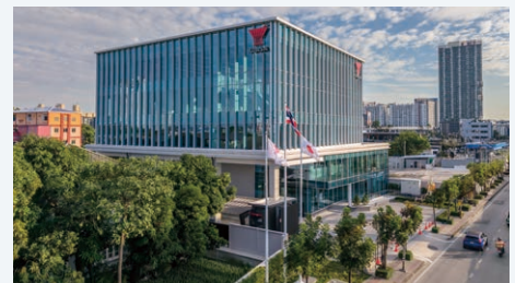
ユアサ商事 バンコク事務所新築工事
