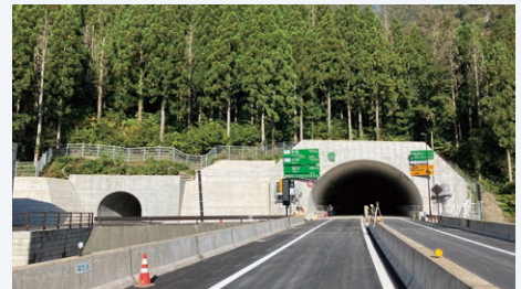
大野油坂道路荒島第2トンネル下山地区工事
