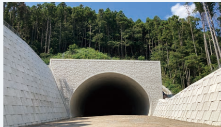
長崎497号松浦1号トンネル新設工事
