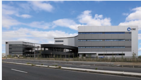
ロジスクエアふじみ野A・B新築工事
