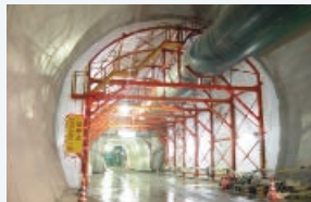
トンネルバルーン
