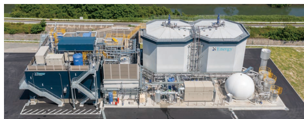
熊本西部バイオガス発電所
