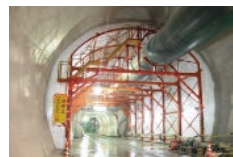
トンネルバルーン
