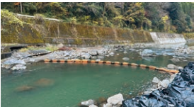
シルトフェンスの設置（玖珠川取水堰出張所）
