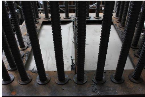
写真4 柱天端の養生状況
