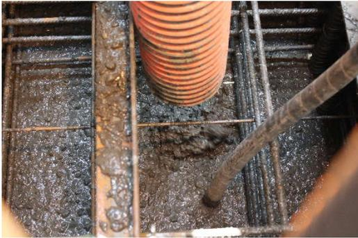
写真3 柱部材への打込み状況
