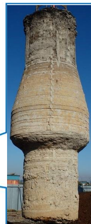
Me-A工法による杭体
