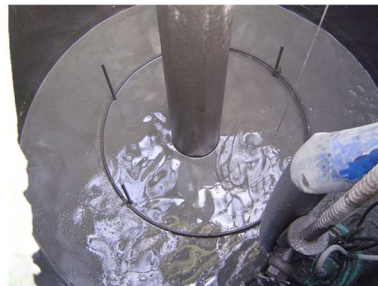
コンクリート打設
