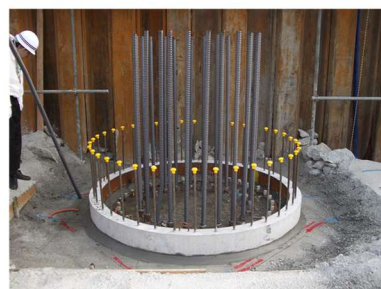
モルタル打設・引張定着筋挿入
