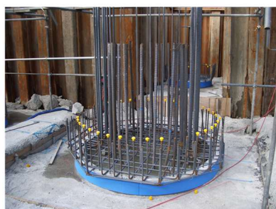
発泡ポリエチレン設置
