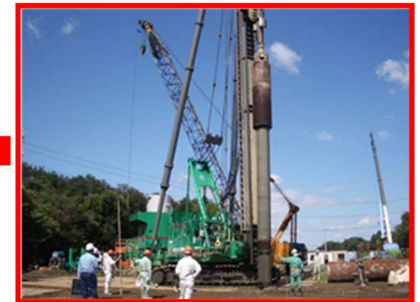
二重管杭建込み
