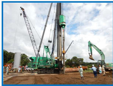
掘削（二重管杭一体化用）
