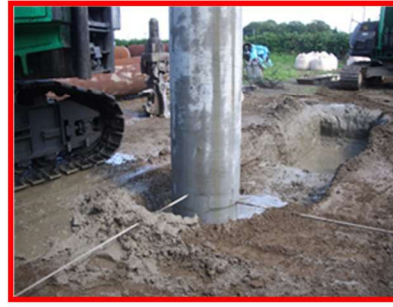
杭心ずれ確認
