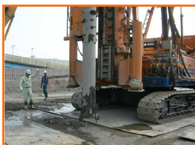
杭芯確認・ケーシングセット
