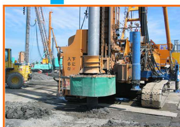
固化杭造成 (ウェーブ施工)
