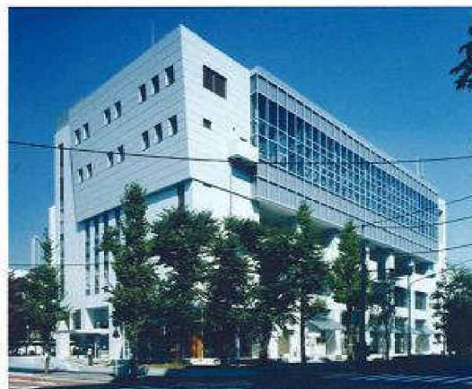
港区スポーツセンタープール棟
