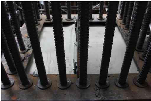
写真4 柱天端の養生状況
