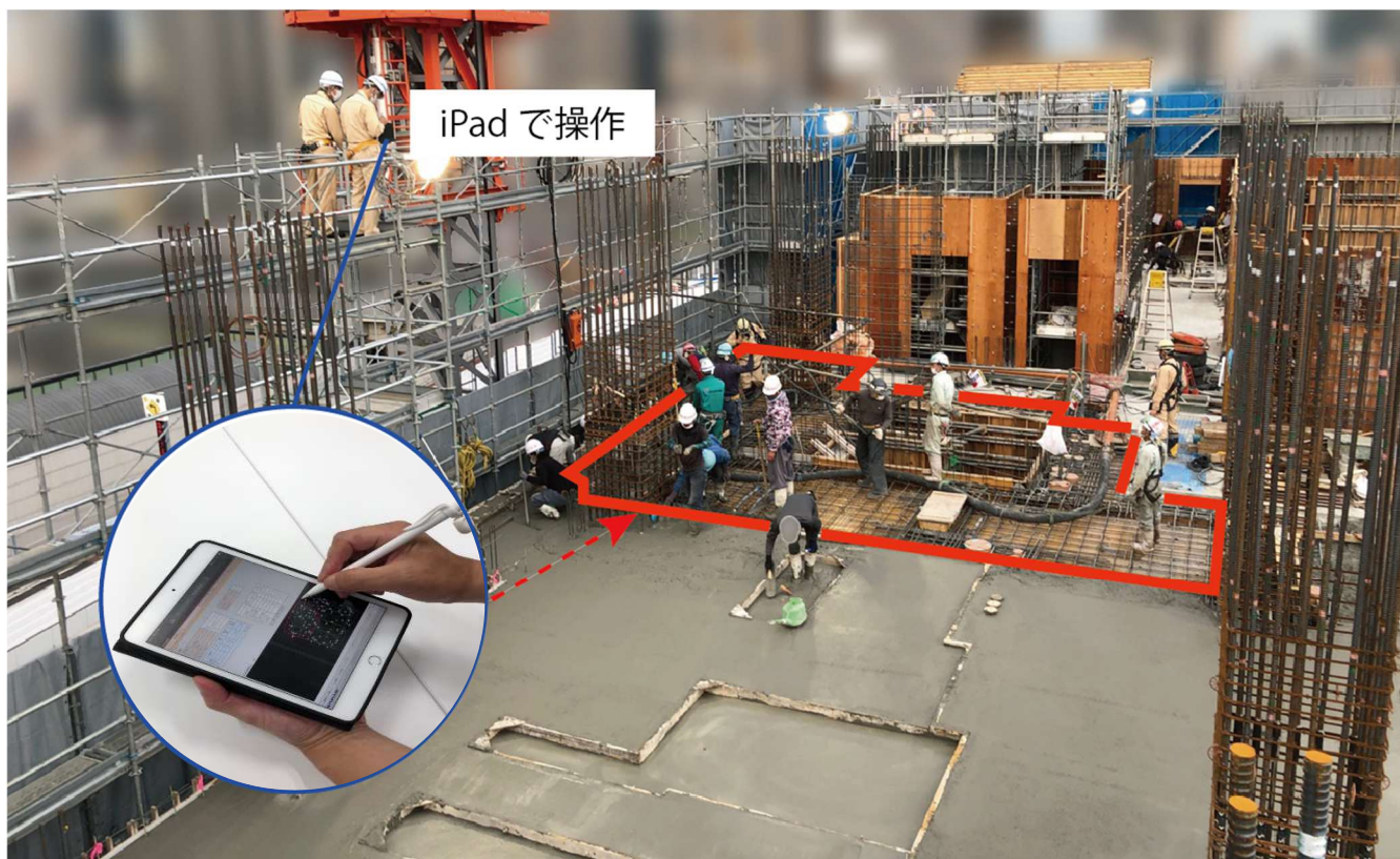
写真1 現場での計測状況
