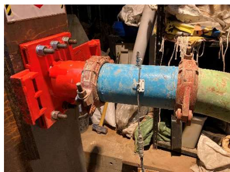
【柱下部】 圧力管理
