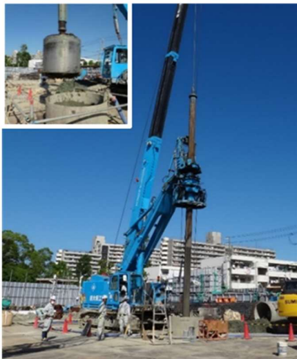
●アースドリル工法
