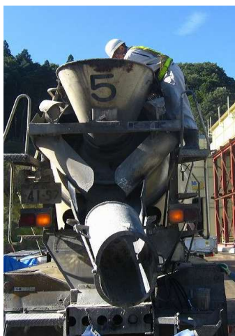
▲現場での後添加状況
