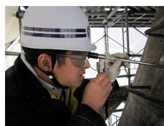
注入状況確認
