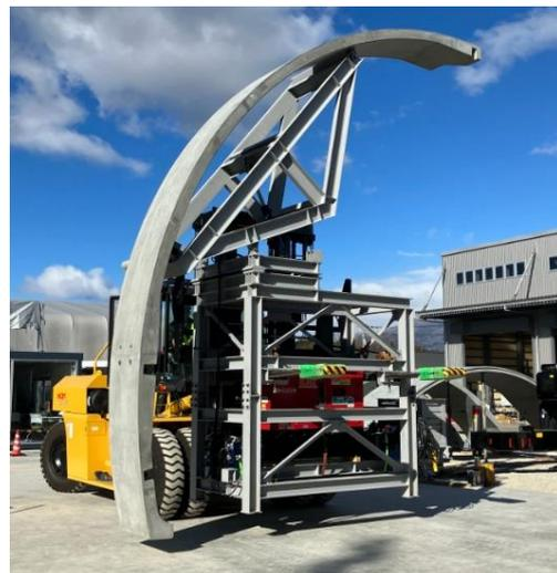
運搬・架設装置への側壁一体型PCL版の積載状況
