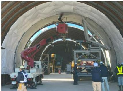
②PCL版架設・接続金物設置
