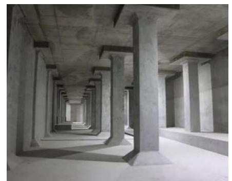
浄水場配水池耐震補強工事 27-15-20N (スラグ70%置換)
