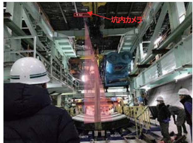
写真-3 坑内カメラによる確認状況
