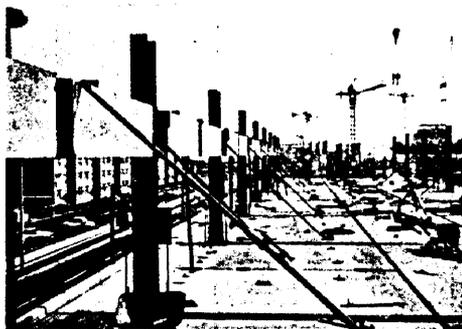
写真-2 桁方向ラーメン材のセット
