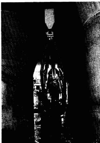
Photo 4 撤去用台車による水中部鋼管杭撤去
