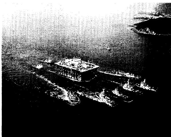
Photo 2 3Pケーソン現地曳航
